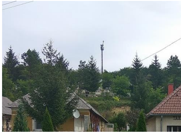
64. ábra Mobil bázisállomás önálló antenntartó szerkezeten
